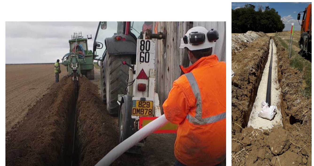
Figure 271: Création de tranchées, source JPEE.
