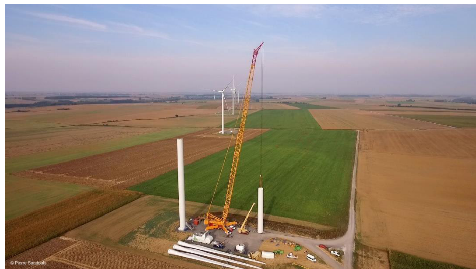
Figure 270: Vue aérienne d'une plateforme de montage, source JPEE.
